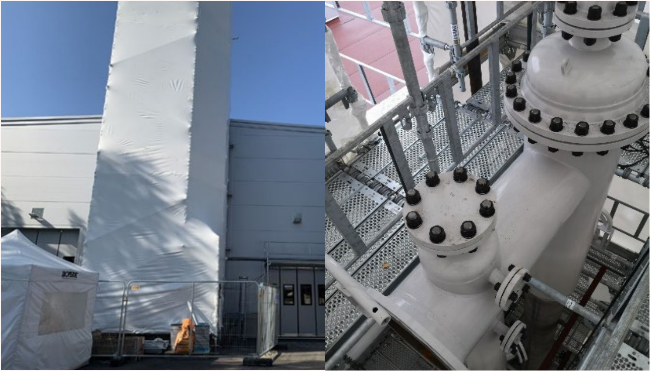
Figur 12: Humphreyriggen, under uppförande i Piteå hos RISE. Vänster: huvudstrukturen och höger tryckkärnen under installationsfasen. Driftsfasen är maj-oktober 2023 som del av Bio-FlexGen och Biokraft 2023!.
