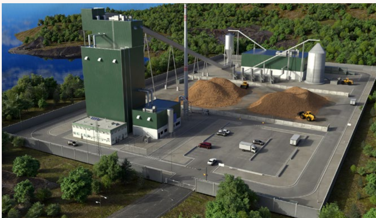
Figur 1: 10 MW BTC anläggning. Källa: Phoenix BioPower
