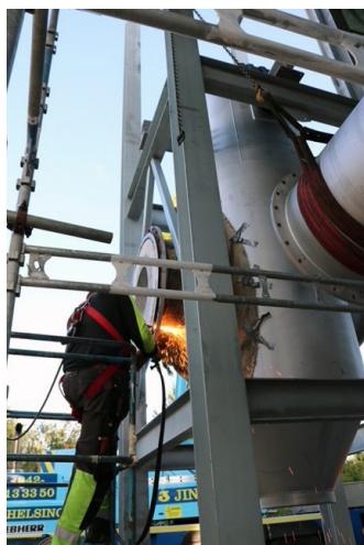
Installationsarbete i Höganäs
