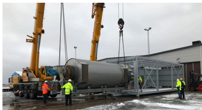
Pyrolysoverdel lyfts in i modul
