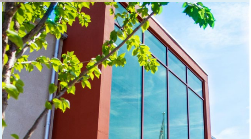
KONTOR ESKILSTUNA, SVERIGE Energimyndigheten 34 m 2 | ConverLight®
