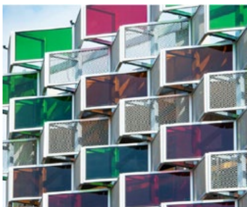
Parkeringshus i Linköping som fått en vacker och funktionell utformning med SolTech ST moduler.
