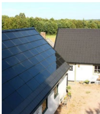
RooF monterad på en Skånelänga. Produkten läggs direkt på läkten (rekommenderat läktavstånd 620-640 mm) och fungerar både som solcell och som taktäckningsmaterial. Produkten är gjord för att tåla väder och vind och för att gå på, vid eventuell service. Nominell effekt är 85W +/- 10 % per enhet.
