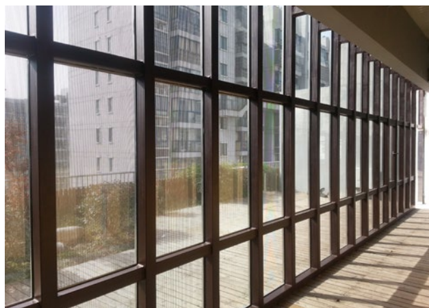
En vägg helt bestående av semitransparenta tunnfilmssolceller av samma typ som marknadsförs av SolTech Energy på skandinaviska marknaden, och som även kan installeras av ASRE i de fall kunden uppför en ny byggnad.
