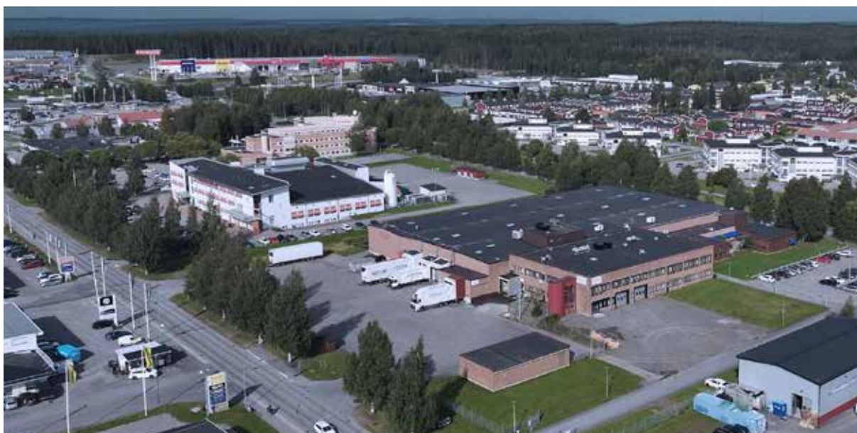
Bolagets tillverkningsanläggning i Umeå med en total yta om 2 200 kvm.
